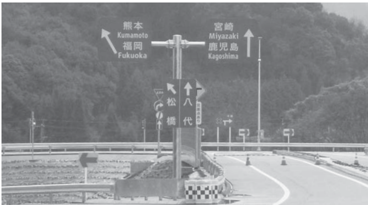
完成した宇城氷川スマートインターチェンジ
