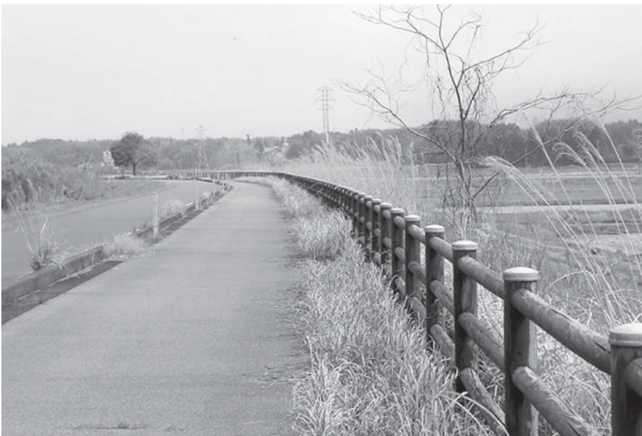
きれいな管理が望まれるサイクリングロード
