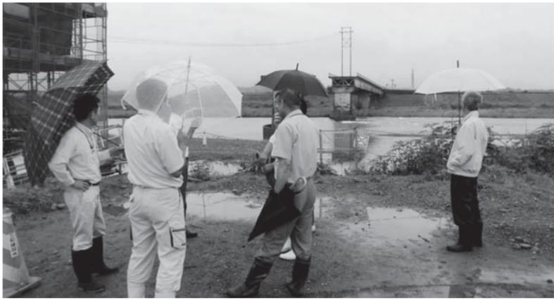
昨年から取り組んだ1期工事で、既に上部工撤去は4径間分が完了。橋脚2基の補強工事が行われており、コンクリートを増し厚するた
