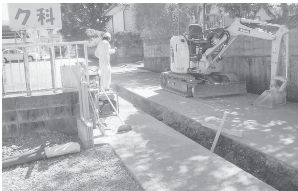
整備が進む水道工事
