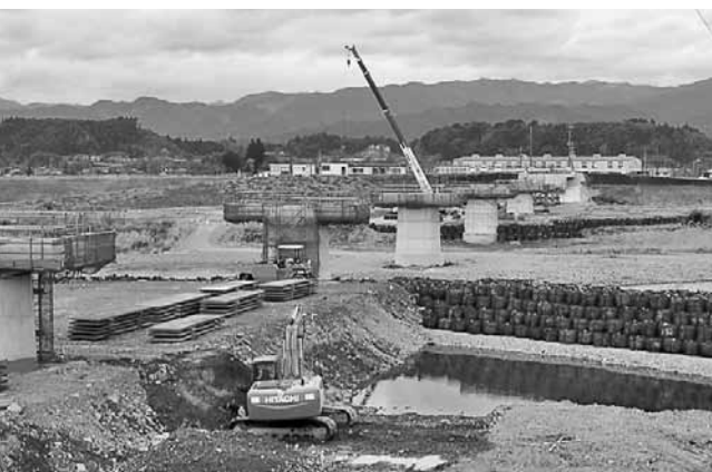
工事が進む錦大橋
