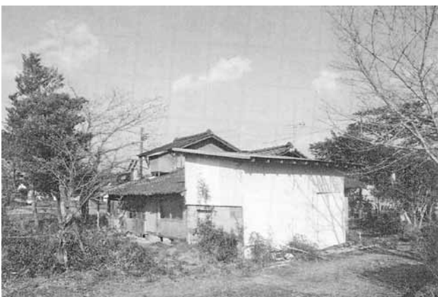
対策が望まれる空き家
