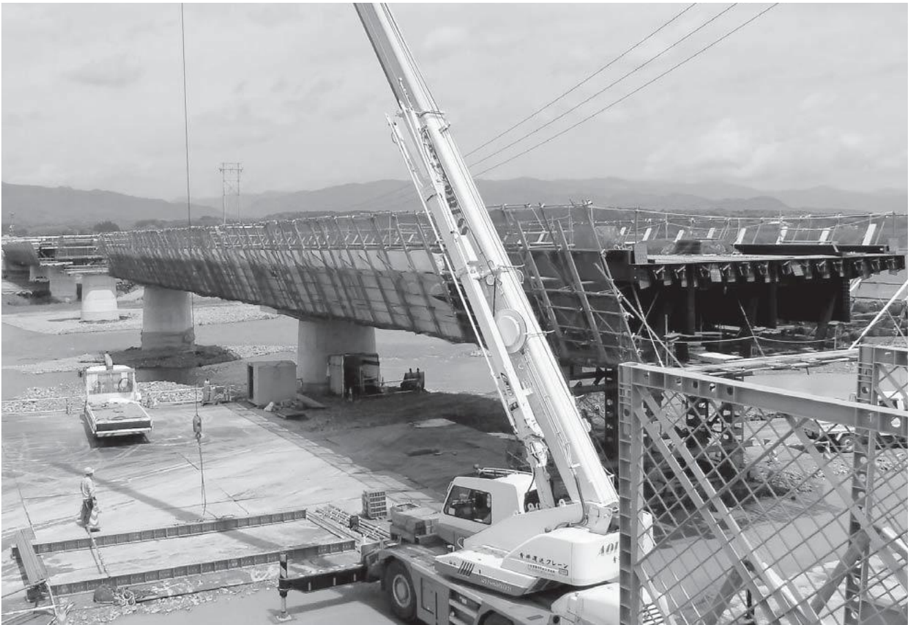
完成間近の錦大橋
