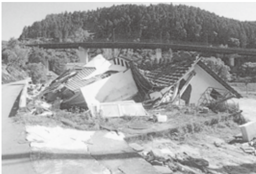
地震により倒壊した家屋(西原村)
