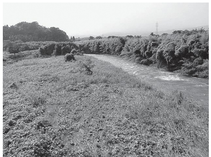
小さで川の堆積土砂（京の峰橋から）
