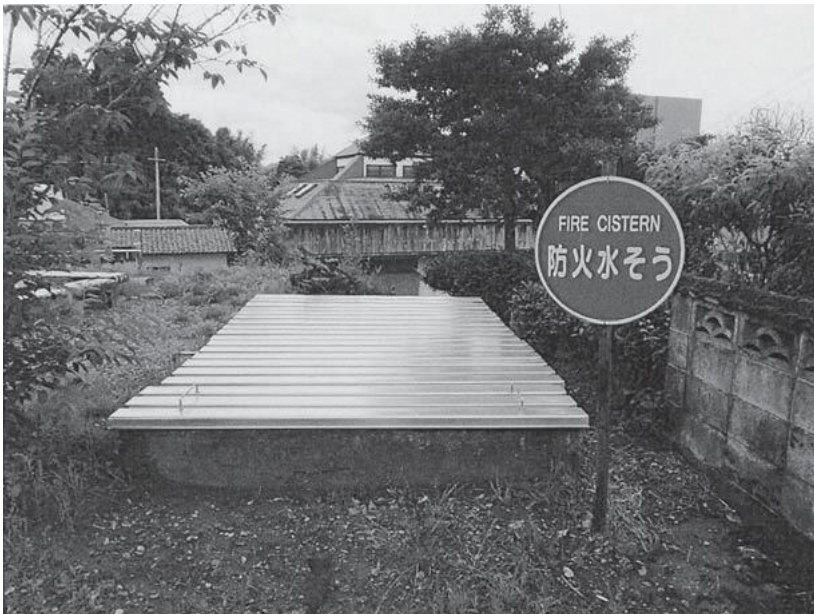
検討が必要な防火水槽
