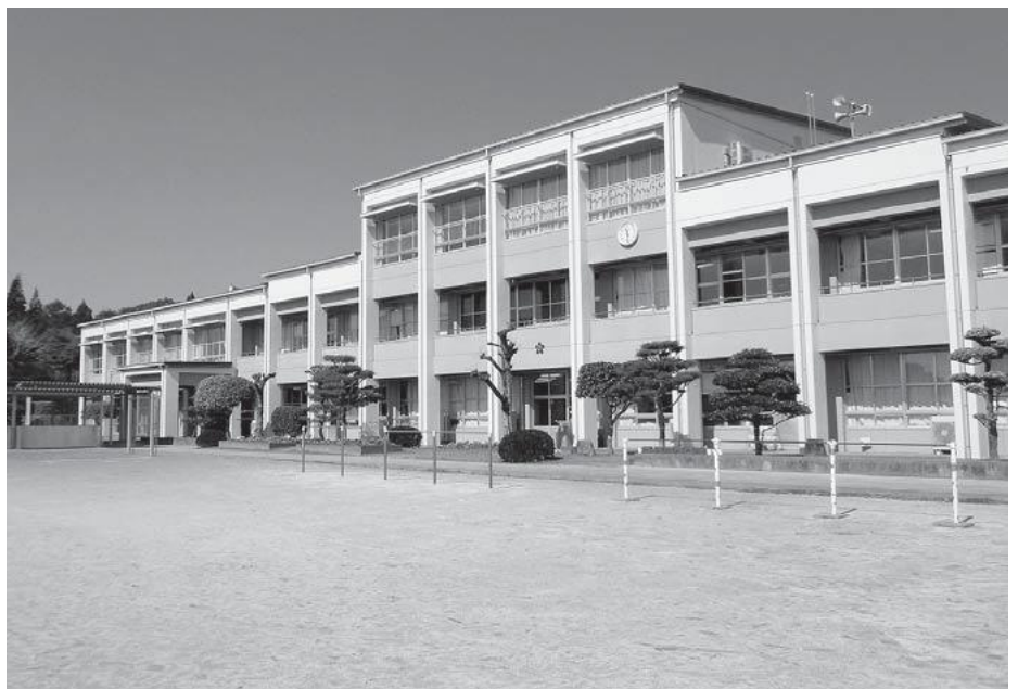
LEDサーチライト設置予定の木上小
