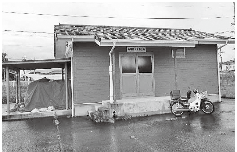
西コミセンに隣設した防災備蓄倉庫
