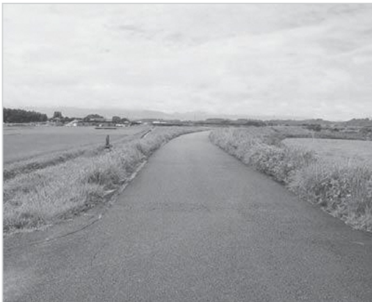
通学路である平良堤防線の現状
