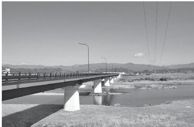
竣工後1年半経過した錦大橋
