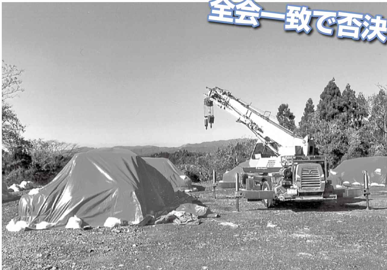
汚染土の搬出状況（12月12日）
