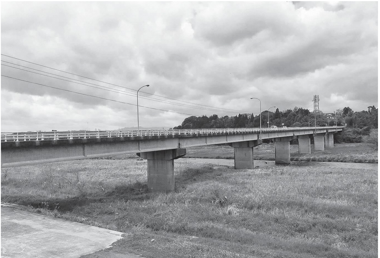
補修改良が計画されている木綿葉大橋
