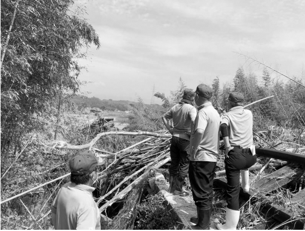
流失した球磨川第四橋梁 (R2.8.3)
