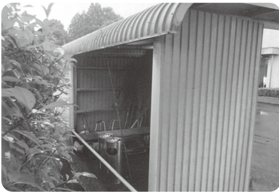
健康増進法（受動喫煙防止）の改正の弊害により、リニューアルできない掃除道具小屋？
