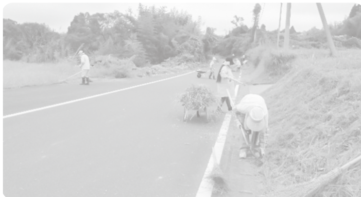
町道手入れ実施中
