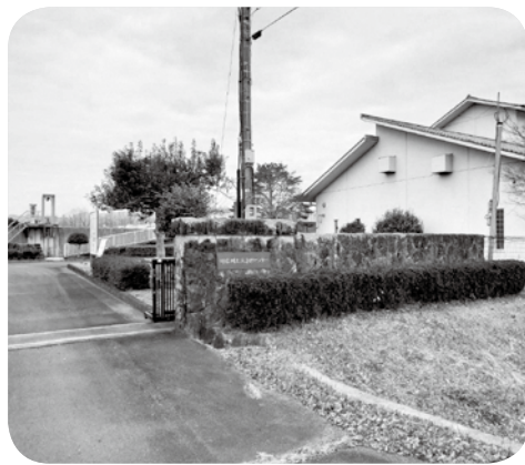
熊本県球磨川上流浄化センター
