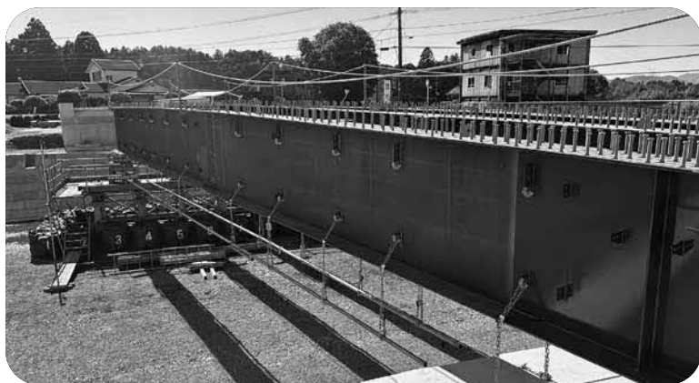
整備が進められる町道松里永野線・黒辺田野橋
