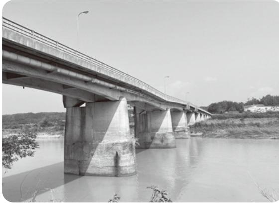
橋脚が沈下した球磨大橋
