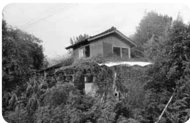
所有者のいない朽ちて行く空き家
