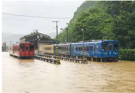
▲豪雨災害で浸水被害を受けた車両
