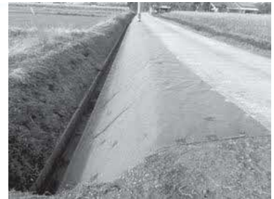
防草シート敷設後
