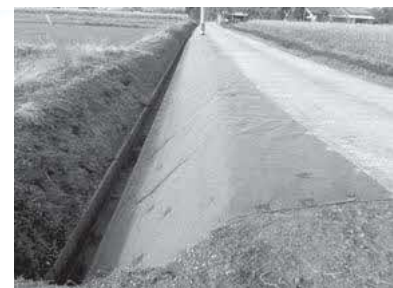
防草シート敷設後
