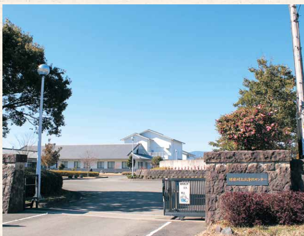
球磨川上流浄化センター
