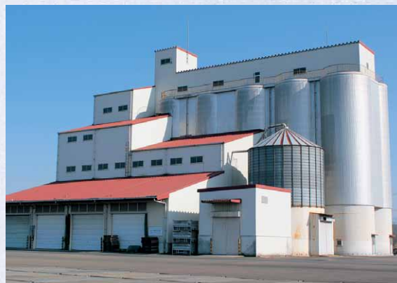
カントリーエレベーター
