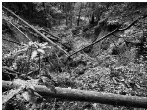
⑥ 戸平山 山腹工着工前
