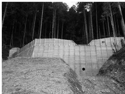
⑤ 藤の尾 谷止工完成后
