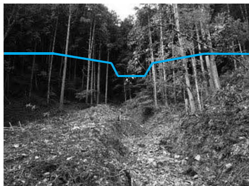
⑤ 藤の尾 谷止工着工前
