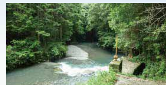
新田頭首工 (H24.7.10 撮影)
