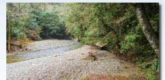
土砂で埋まったままの新田頭首工(復旧中)
