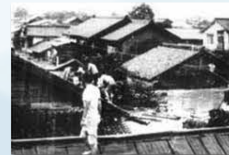
人吉市青井町の浸水状況
