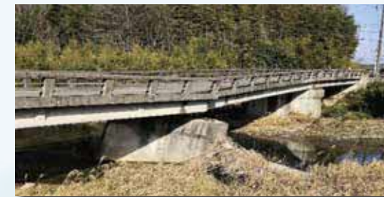
水無川橋 (一武福島地区)
