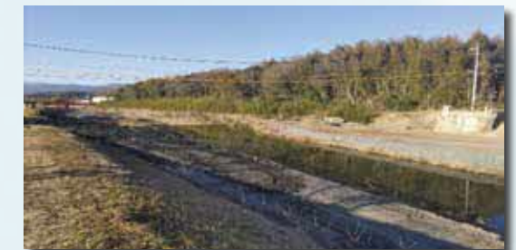
復旧中 (被災橋梁撤去)
